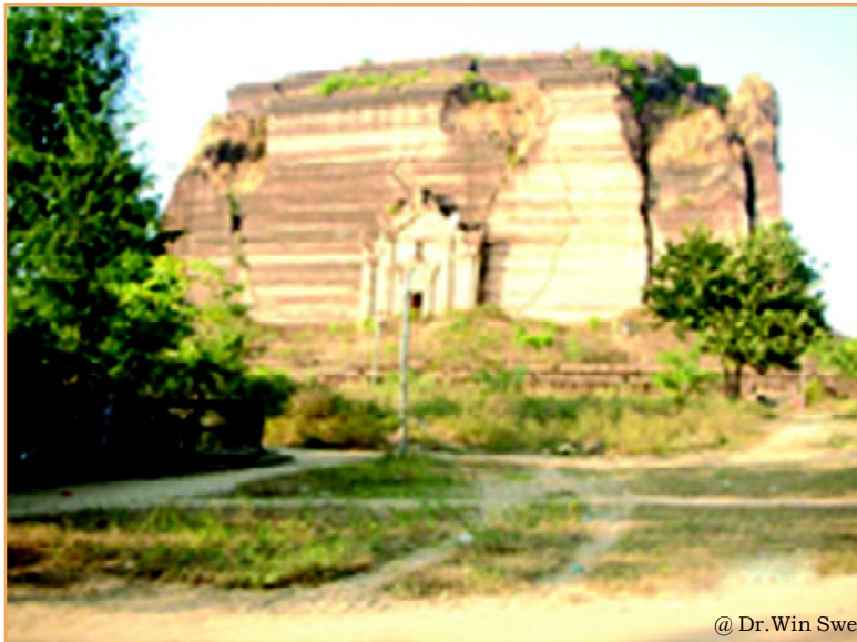
မင်းကွန်းစေတီကြီး၊ တည်ဆောက်၍မပြီးသေးမီ ၁၈၃၉ ငလျင်တွင် ပြင်းထန်စွာ ထိခိုက်ခဲ့ကာ ၁၉၅၆ ငလျင်ကြောင့် ထပ်မံပျက်စီးခဲ့ရသည်။
