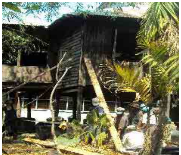
တည့်မတ်မှုရရန်ဒေါက်များဖြင့် ထောက်ထားပုံ
