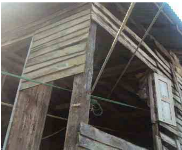
အဆောက်အအုံပြန်တည့်မတ်စေရန် ကြိုးများဖြင့်သိုင်းဆွဲထားပုံ
